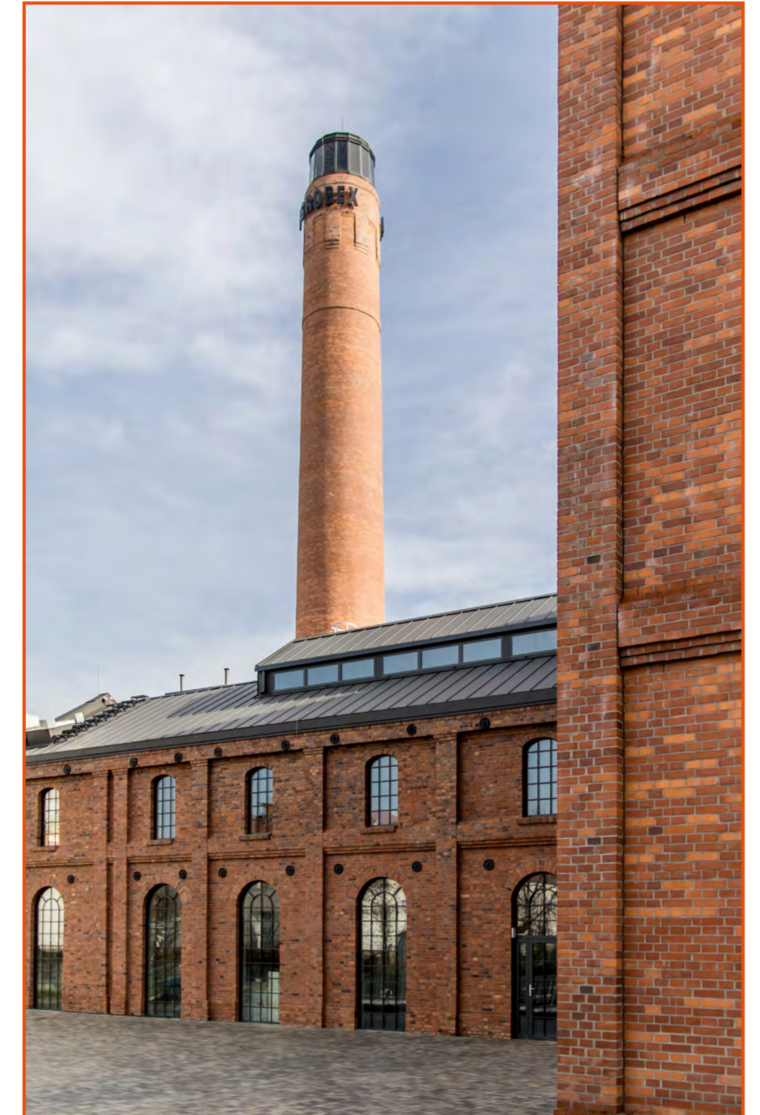
Spalarnia śmieci na Wilczaku po rewitalizacji w 2020 r., elewacja niższej części budynku i zrekonstruowany komin, proj. pierwotny Stanisław Kirkin (1927), proj. przebudowy Litoborski+Marciniak Biuro Architektoniczne sp. z o.o.
